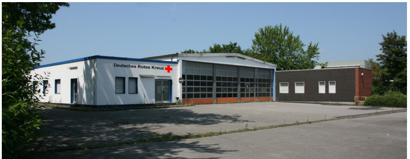
Das künftige Rotkreuzzentrum an der Kölner Straße in Recklinghausen
